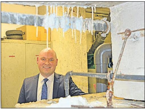
Tim Kuhn, der Leiter des technischen Gebäudemanagements, zeigt im Untergrund Stalagmiten und Stalaktiten. Foto: js
