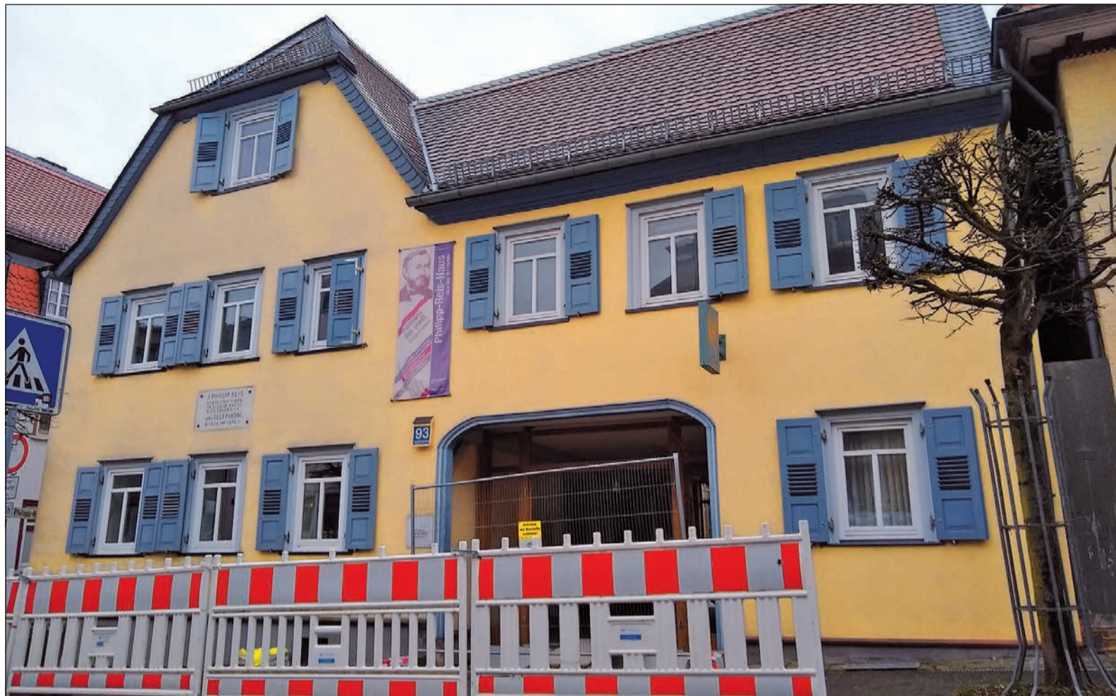
Bauzäune weisen schon seit November 2019 auf die Arbeiten am ehemaligen Wohnhaus des Telefonerfinders Philipp Reis hin. Es wird erweitert und modernisiert. Foto: Philipp-Reis-Haus
