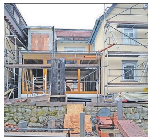
Ein Anbau mit Aufzugsschacht erweitert das historische Gebäude, in dem vor 160 Jahren der Telefonerfinder Philipp Reis wohnte und in dem heute das Museum untergebracht ist.
