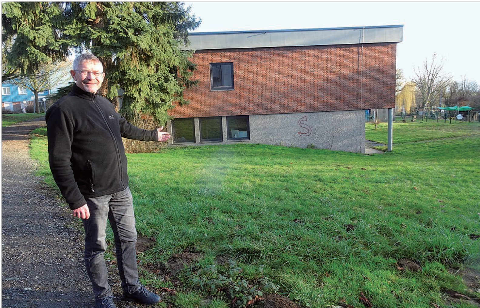
Pfarrer Werner Böck zeigt auf die Wiese neben dem Gemeindezentrum, die als Baugrund für 15 Senioren-Wohnungen vorgesehen ist. Foto:HB
