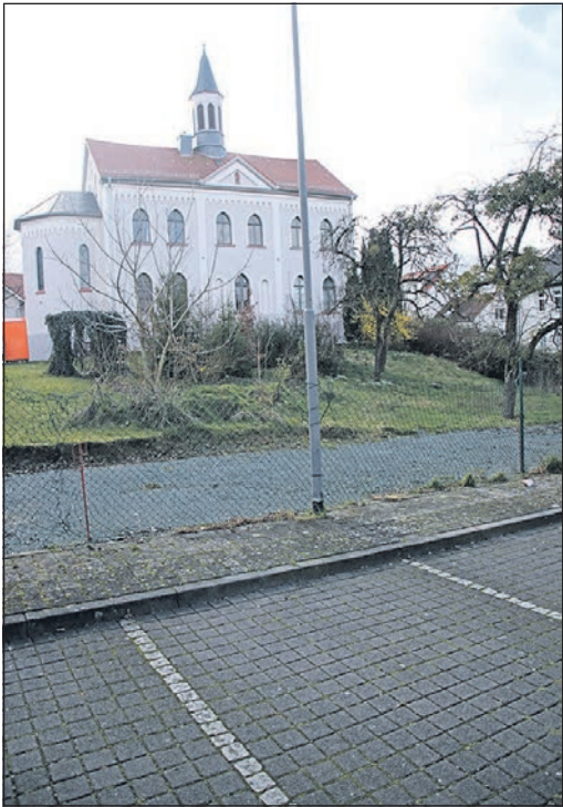
Hinter den bestehenden Parkplätzen am Schwesternhaus soll im Bereich des Schwesternhausgartens eine weitere Parkreihe entstehen. Die Vorbereitungen dazu sind bereits getroffen. Foto: Ehmler
