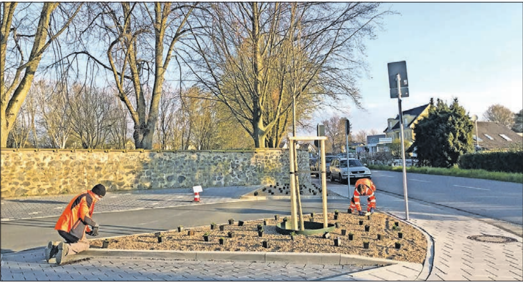
Am Friedhof in Ober-Eschbach wurden die neuen Beete am Parkplatz und im Eingangsbereich blütenreich bepflanzt. Foto: Stadt Bad Homburg
