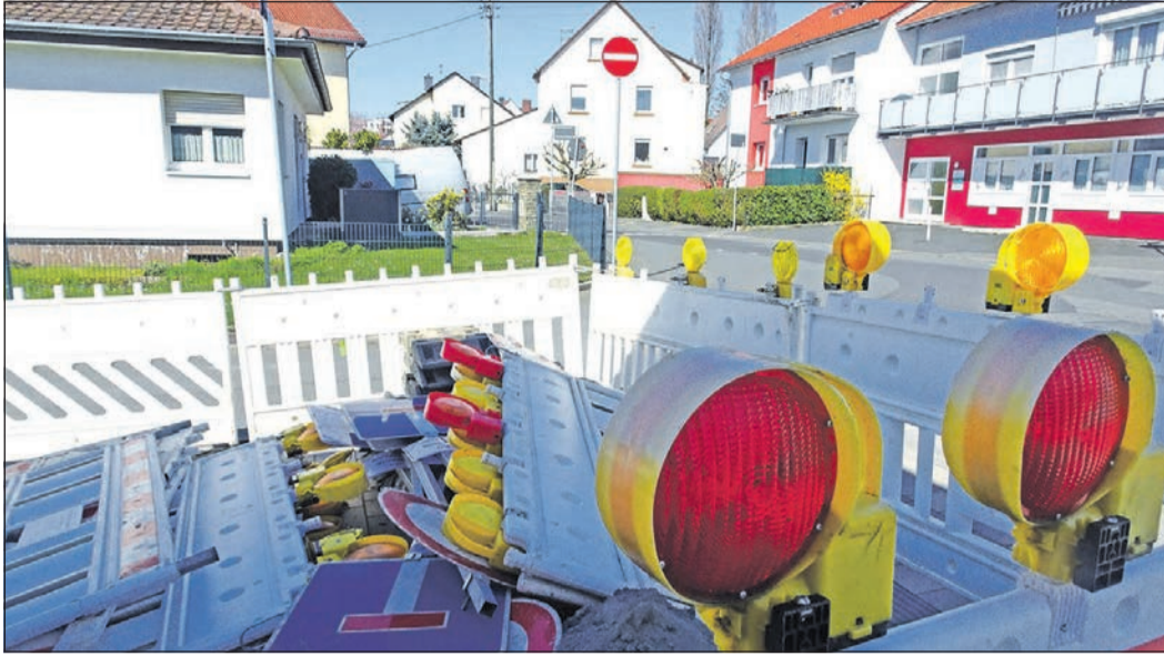
Schilderdepot an der Untergasse. Die Bauarbeiten verzögern sich.
