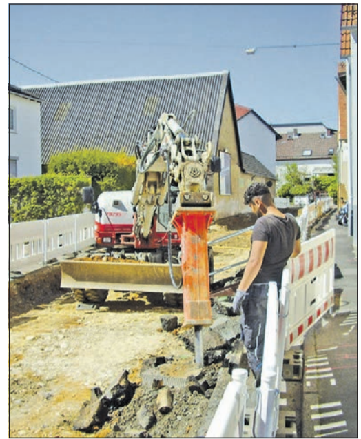
Die Arbeiten an der Baustelle Untergasse dauern voraussichtlich bis August. Foto: HB
