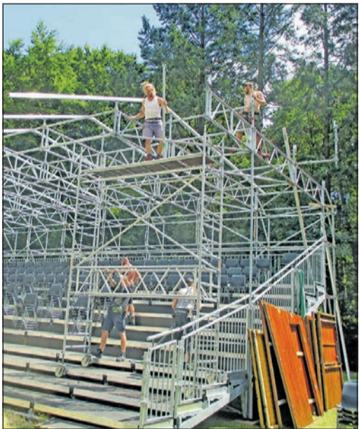
Das wird es in diesem Jahr nicht geben, Tribünen-Aufbau im Sommer 2019. Foto: bg
