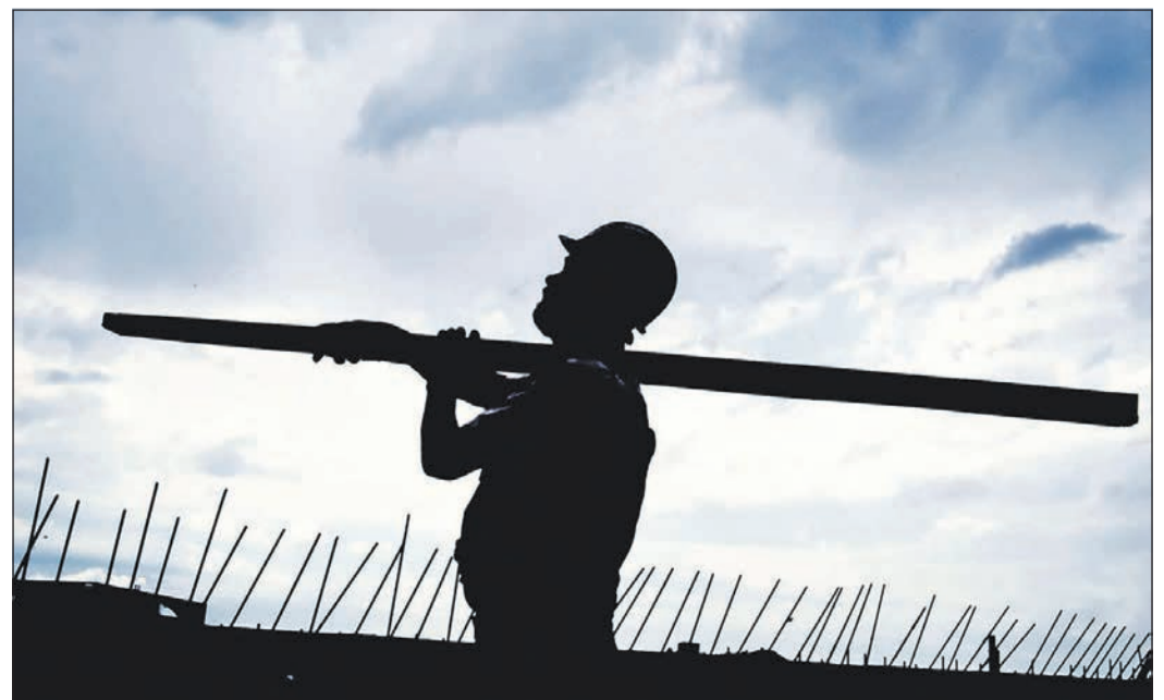
Schwer zu tragen: Bauarbeiter haben auch in der Corona-Krise viel zu tun. Für sie fordert die Gewerkschaft IG Bau jetzt höhere Löhne und die Bezahlung von Fahrzeiten. Foto: IG Bau
