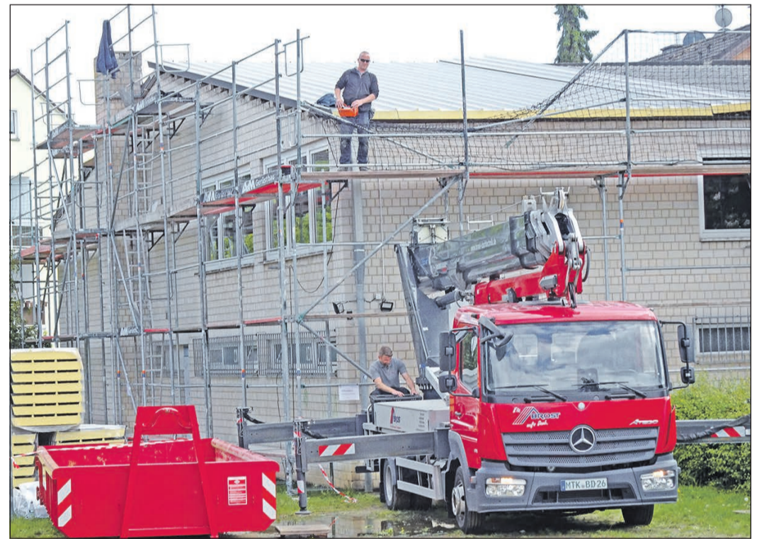
An der Dachbaustelle der Friedrich-Hill-Halle wird mit Nachdruck gewerkelt. Fotos: HB
