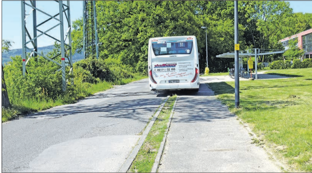
Am Ende der Waldstraße erhält der Bus eine Wendeschleife.
