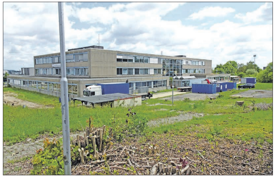
Das alte Zentralgebäude der Integrierten Gesamtschule Stierstadt in der seinerzeit topaktuellen Waschbeton-Optik wird demnächst fallen. Fotos: HB
