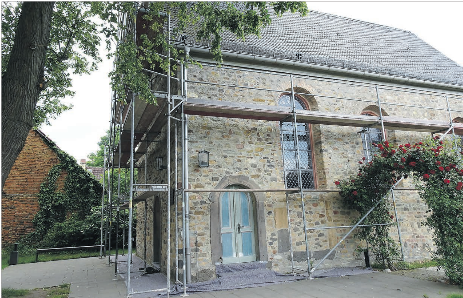
Die eingerüstete St.-Georgs-Kirche gilt als Wohlfühlort der evangelischen Gemeinde.
