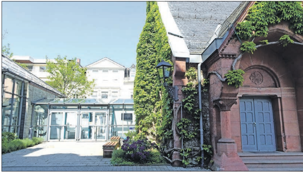
Die Eingänge zur Englischen Kirche würden eine Trennung von Zu- und Abgang ermöglichen. Notfalls könnte auch die blaue Eingangstür rechts als Zugang benutzt werden. Foto: Staffel
