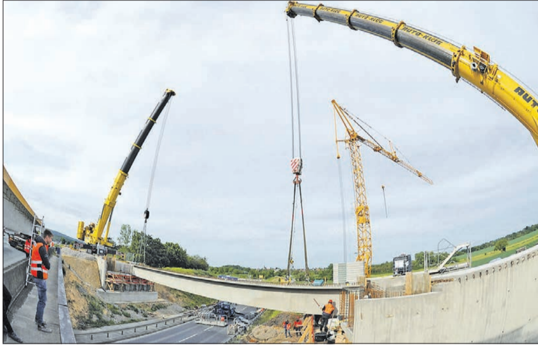
Zwei riesige Kräne platzen die vier 34 Meter langen und 116 Tonnen schweren Betonriegel an der vorgesehenen Stelle. Foto: fk
