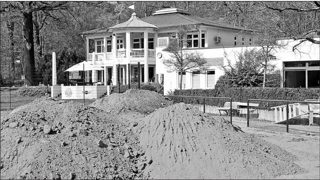
Auf der Anlage des TC Bad Homburg wird im Kurpark derzeit an den Rasenplätzen für die „Bad Homburg Open“ gearbeitet. Foto: gw
