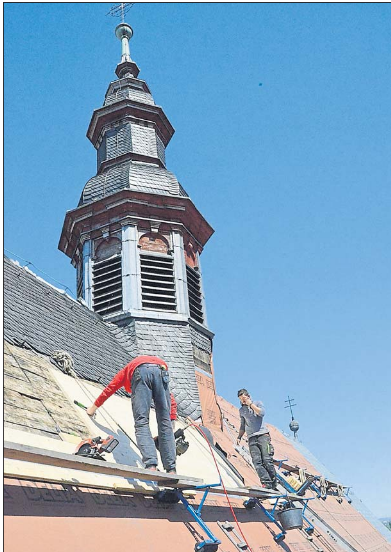
Nur noch wenige Schieferplatten waren auf dem Dach der Pankratiuskirche anzubringen, als das Foto entstand. Foto: Fördervereins Pankratiuskirche e.V.
