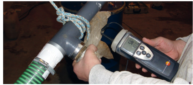
Abb. 1: Fallbeispiel 1 – Messung von Temperatur und Feuchte in der Messstrecke
