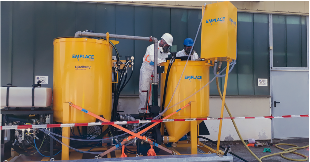
Abb. 4: Durchführung der Injektionen (Sanierung im technischen Maßstab)
