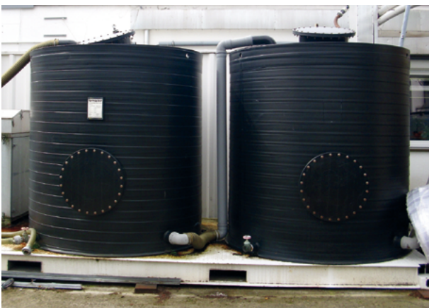
Abb. 6: Fallbeispiel 4 – Zwei 4 m 3 große Luftaktivkohlefilter im Freien
