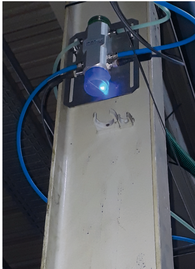
Abb. 5: Bauwerksüberwachung mittels Sensoren an den tragenden Bauteilen
