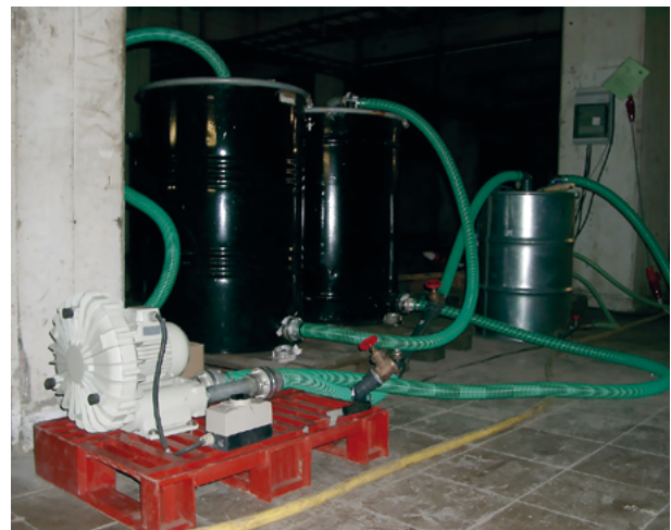
Abb. 3: Fallbeispiel 2 – Seitenkanalverdichter mit 1,1 kW
