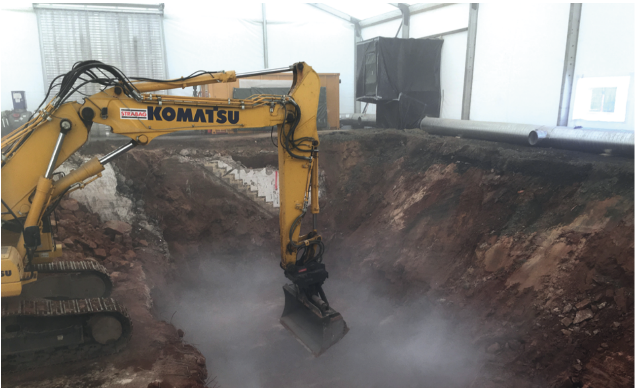
Abb. 3: Bodenaushub innerhalb der Einhausung; im Hintergrund Reste der Altgebäudesubstanz
