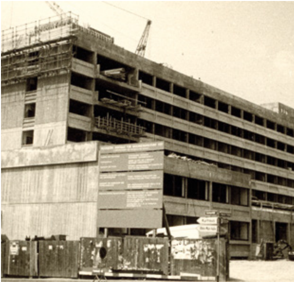
1970: Rohbau des HZD Haupthauses in der Mainzer Straße. Das ehemalige Rechenzentrum der hessischen Landesverwaltung wurde aufgestockt und erweitert.
