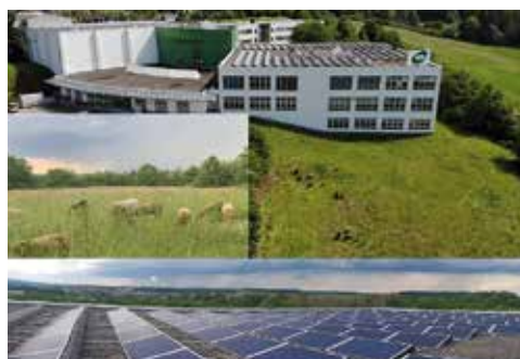
Das Betriebsgebäude mit Schafherde, PV-Anlage mit Gewitter
