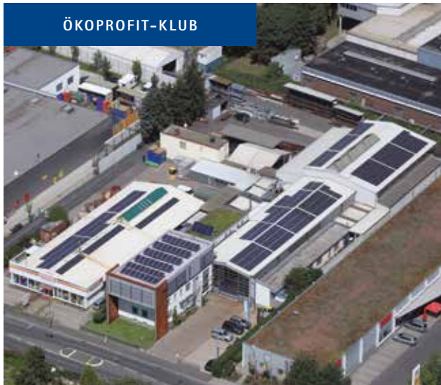
Gelände der Firma Huhle mit Photovoltaik-Anlage
