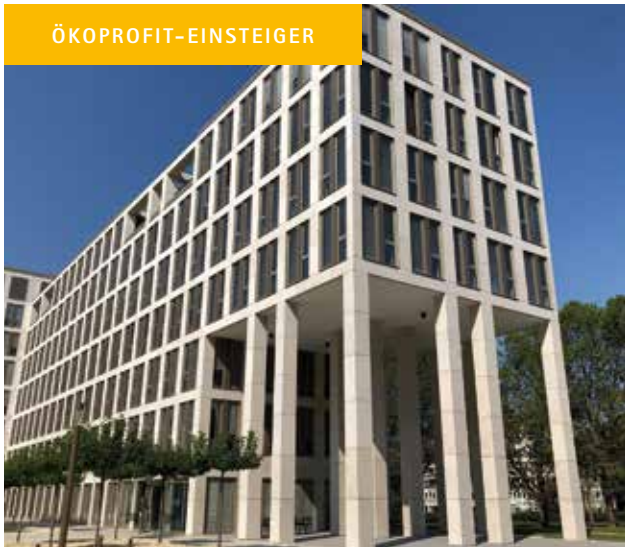
SOKA-DACH im Büroquartier VERSO in Wiesbaden
