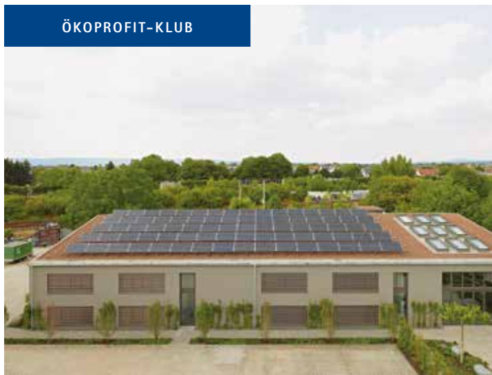
Das neue Gebäude mit effizienter Photovoltaikanlage
