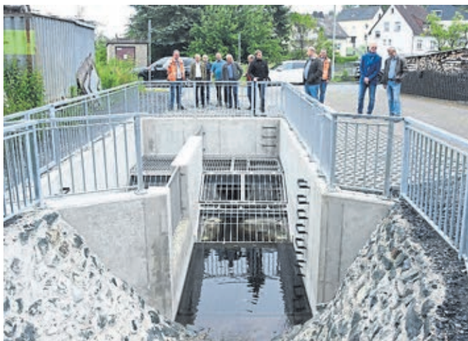
Ortstermin am fertig gestellten Einlaufbauwerk in Waldhausen. Foto: Bach
