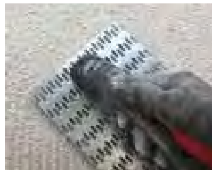
Erstmals kann das Gewebe direkt in den Unterputz eingebettet werden.
