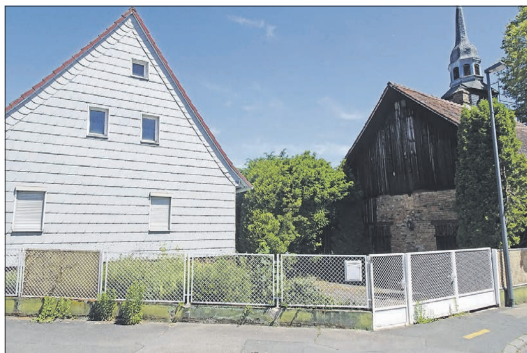
Wohnhaus und Schmiede in der Kirchgasse 7 gehören der Bürgerstiftung, und sollen kulturell genutzt werden. Foto: HB
