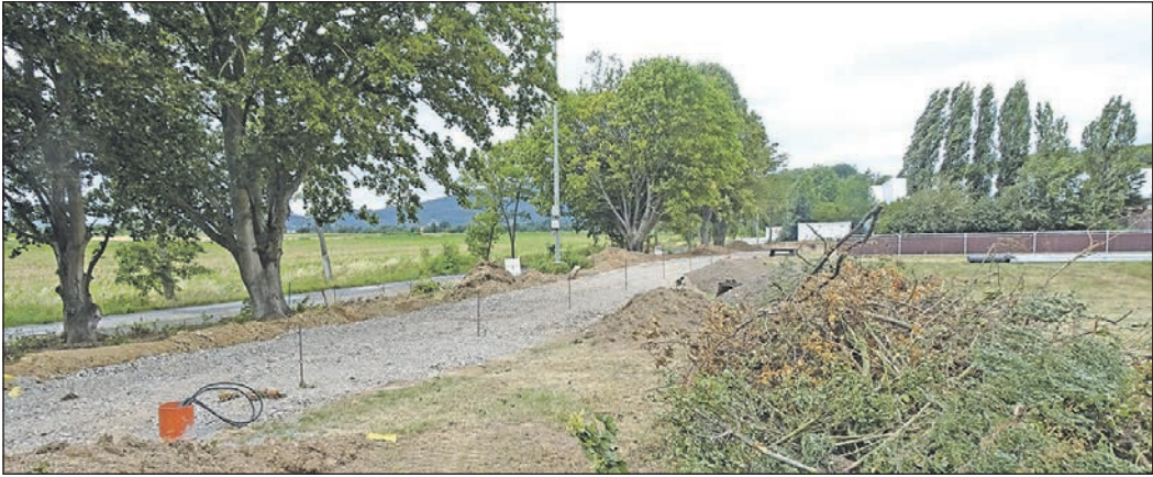
Der Fußweg neben dem Sportgelände hat schon ein Schotterbett.
