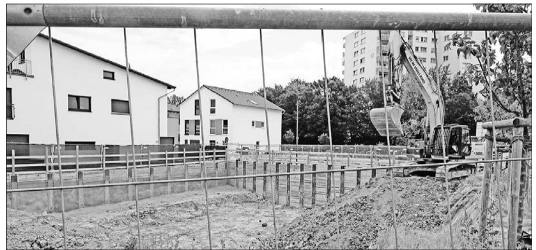
In dieser Baugrube am Römerweg wurde die Phosphorbombe freigelegt.
