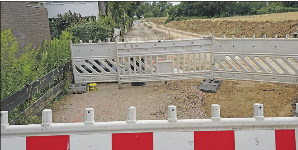
Die Sperre auf dem Nicolaiweg schützt eine verwaiste Baustelle. Foto: HB
