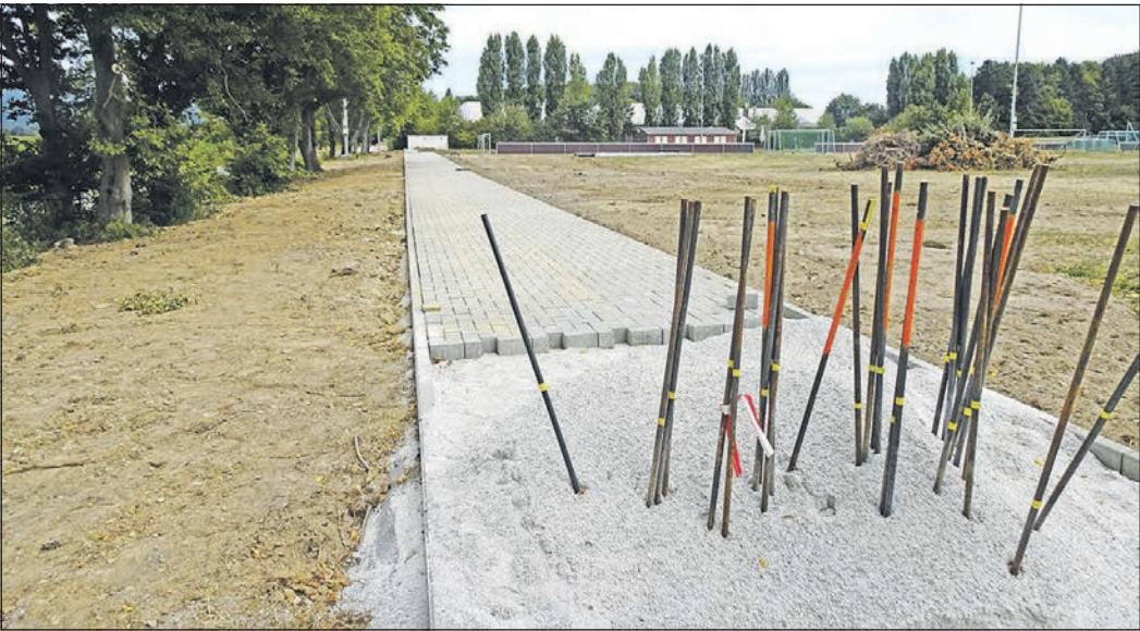
Geh- und Radweg am FSV-Sportplatz: Von Bauarbeitern keine Spur. Foto: HB:
