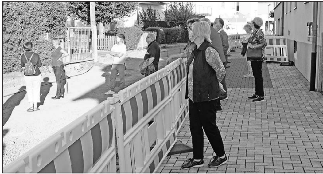
In der Untergasse ist der Gehweg schon gepflastert.
