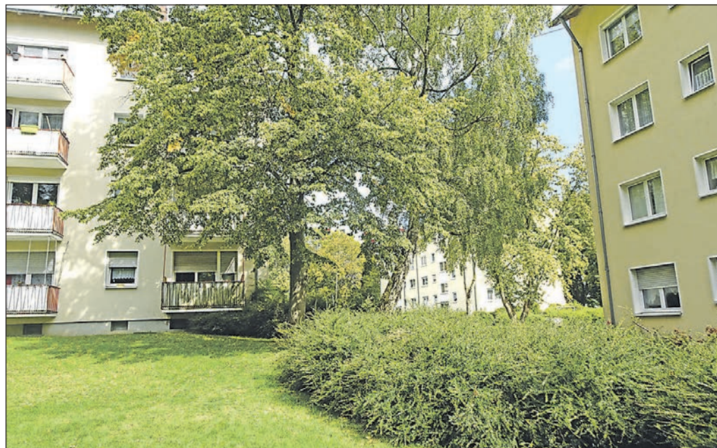
In die Lücke zwischen diesen beiden Wohnblocks am Hessenring werden 15 Seniorenwohnungen gebaut.
