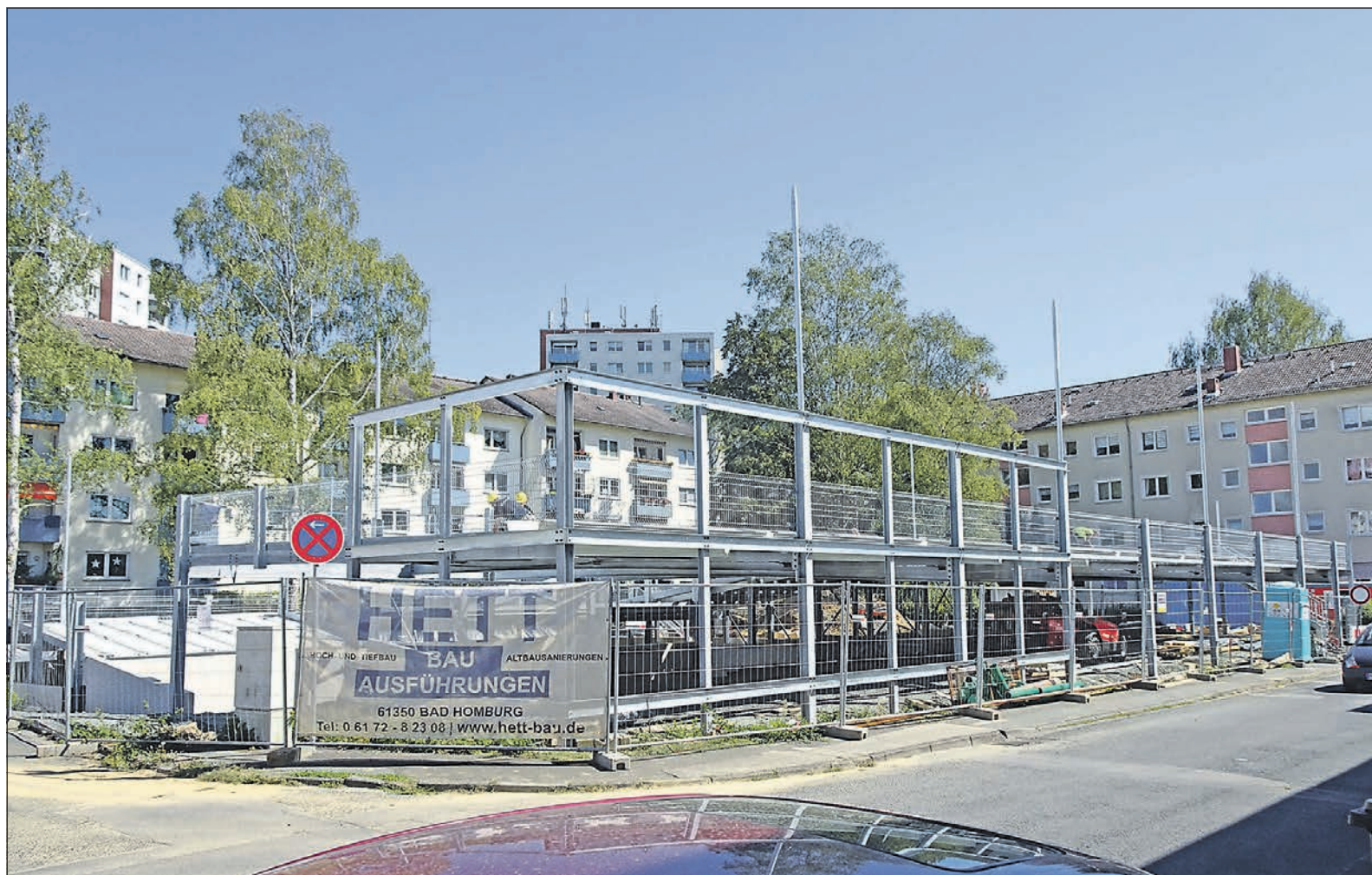
Das Parkdeck, das derzeit an der Wingertstraße errichtet wird, soll 90 Stellplätze haben.
