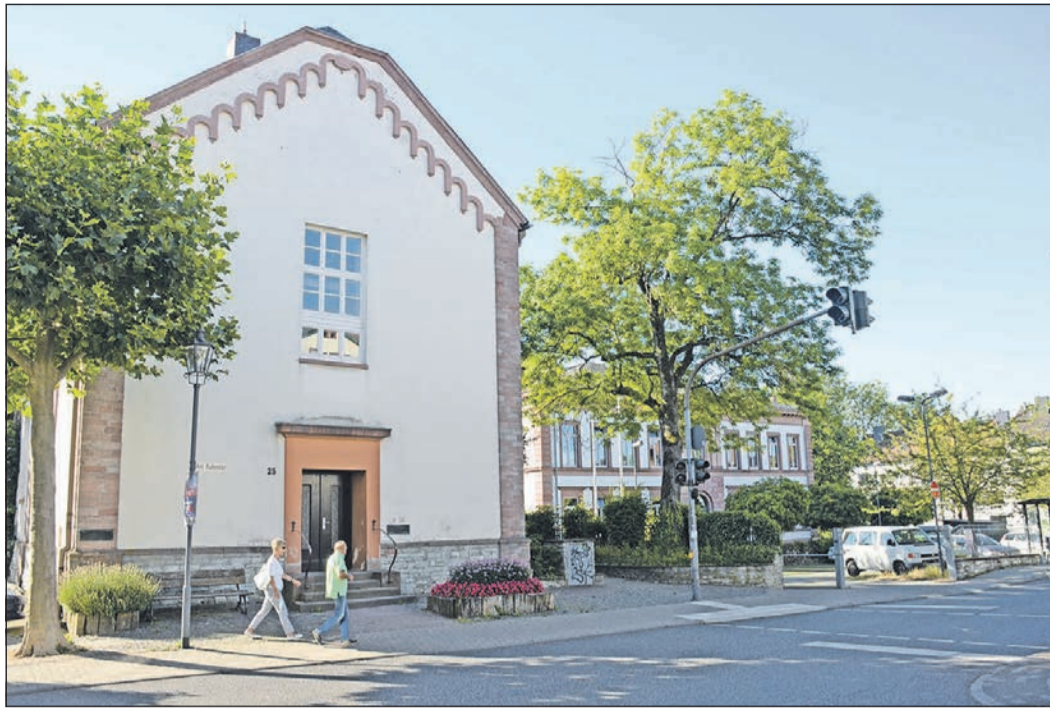
Das Ferdinand-Balzer-Haus neben der Grundschule Mitte wird heute insbesondere von kulturell ausgerichteten Institutionen, Gruppen und Vereinen genutzt. Fotos: js
