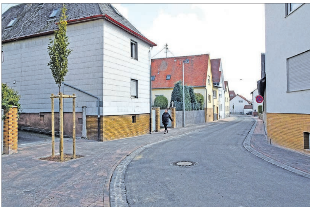
Hainbuchen sind in der Untergasse gepflanzt und die Einmündungen aufgepflastert. Foto: HB
