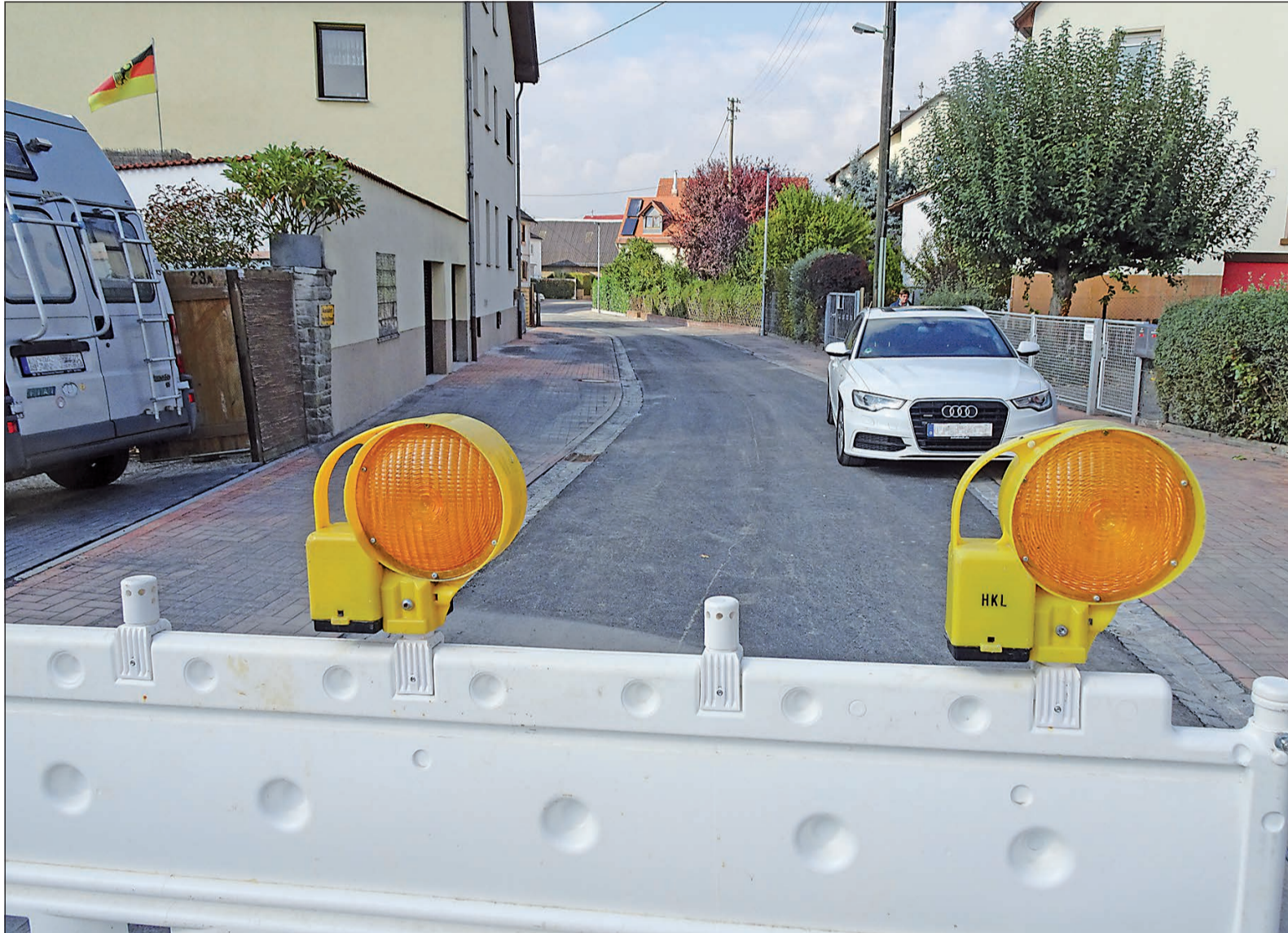
In der kommenden Woche werden die Sperrgitter beseitigt und die Untergasse wird für den Verkehr freigegeben.
