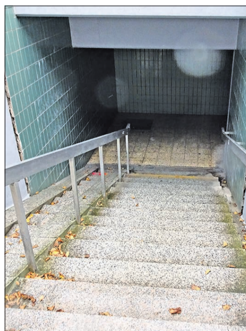
Die S-Bahn-Unterführung ist ein potentieller Angstraum. Foto: HB
