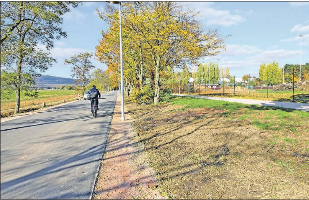
Die asphaltierte Waldstraße ist durchgängig breit genug für Begegnungsverkehr. Auf der rechten Seite verläuft der von der Fahrbahn abgesetzte Fußweg. Foto: HB
