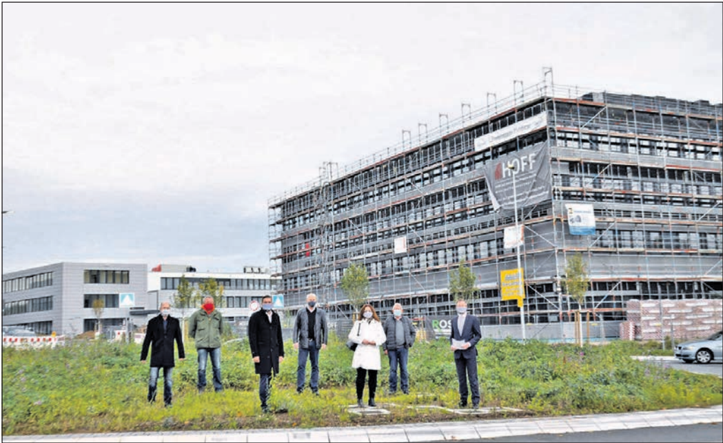
Überzeugen sich vom Fortschritt „Im Gründchen“ (v. l.): Christian Weber (Büro Sommer Ingenieure), Jürgen Post (Faber & Schnepp), Erster Stadtrat Lars Knobloch, Michael Schippers (Terramag), Anika Bodenschatz (Amt für Stadtentwicklung, Bauen & Verkehr), Wilfried Schneider (Terramag), und Bürgermeister Steffen Bonk.
