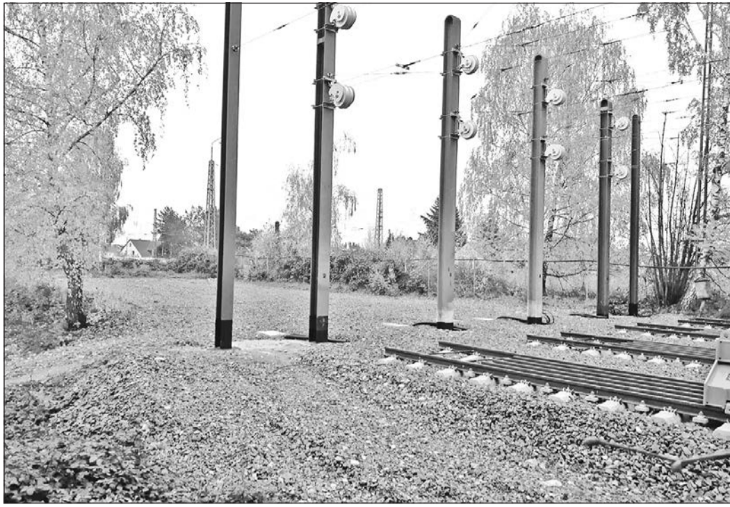
Hinter den finalen Masten zur Stromversorgung der Züge markiert das freie Schotterbett den zusätzlich „eroberten“ Platz für die Ausfahrt von der „neuen Nassauer Straße“ in Richtung Drei-Hasen-Brücke nach dem Deal mit der VGF. Foto: js
