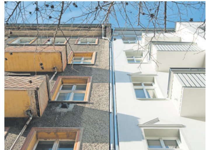
Nicht nur der Anstrich ist nach einer Sanierung wie neu: Die Arbeiten können auch Schäden beseitigen und künftige Mängel verhindern. Foto: Andrea Warnecke/dpa-mag
