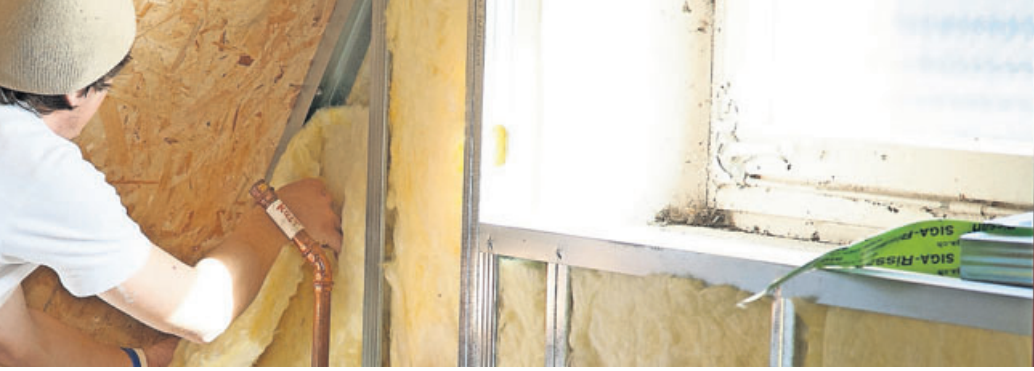
Wer sein Dach dämmt, spart Heizkosten. Nicht für jede Methode muss gleich der Profi ran. Foto: Kai Remmers/dpa-mag
