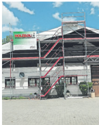
Umbauarbeiten beim Reit- und Fahrverein Distelrasen.
