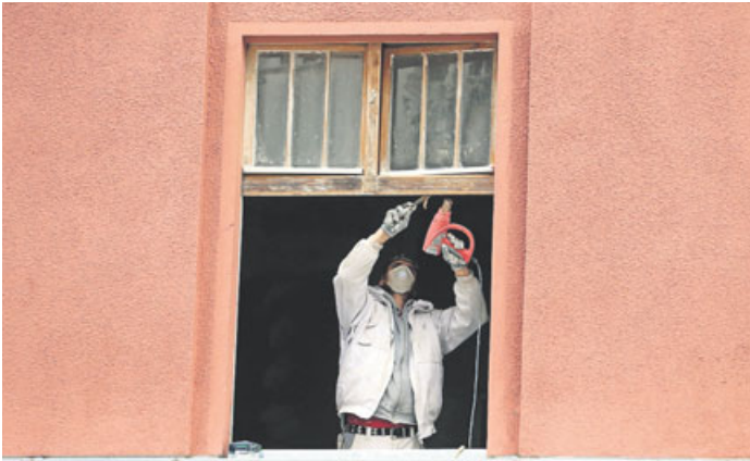
Zugige Fenster? Wenn sich der Zustand während der Mietzeit verschlechtert, muss der Vermieter die Fenster reparieren. Foto: Wolfgang Kumm/dpa/dpa-mag
