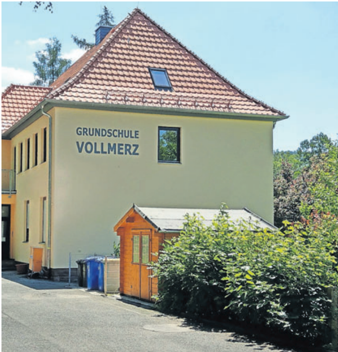
Die Grundschule in Vollmerz präsentiert sich mit neuem Dach und frisch gestrichener Fassade. Der Main-Kinzig-Kreis hat in die Sanierung 190.000 Euro investiert.
