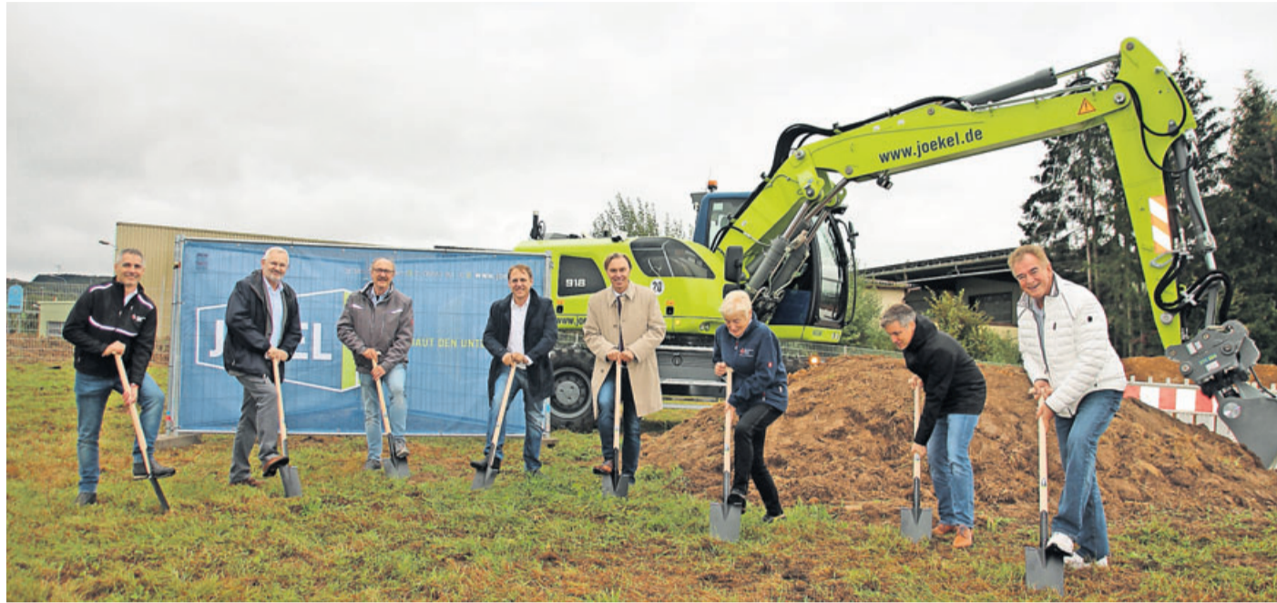
Zahlreiche Gäste versammelten sich zum ersten Spatenstich am Gelände in Schlüchtern.
