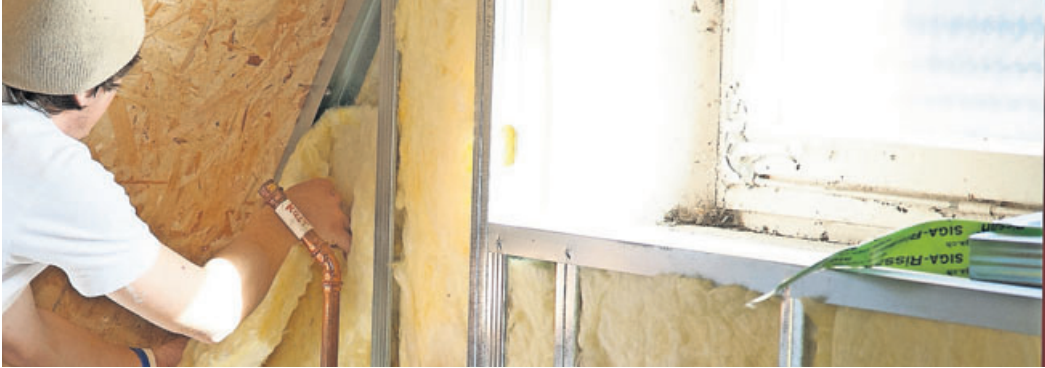
Wer sein Dach dämmt, spart Heizkosten. Nicht für jede Methode muss gleich der Profi ran. Foto: Kai Remmers/dpa-mag
