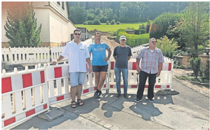
Die Mitglieder der BBB vor der Baustelle.
