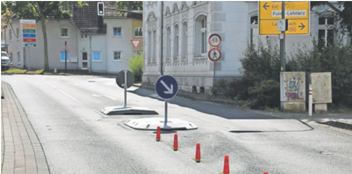
Testlauf der Querungshilfe im Horaser Weg in Fulda.
