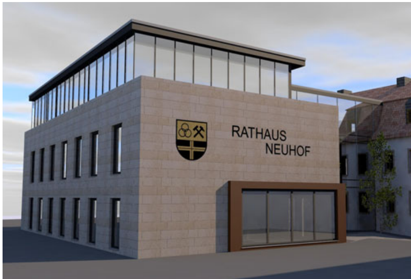
Das nächste große Projekt der Gemeinde Neuho: Neubau des Nebengebäudes des Rathauses.
