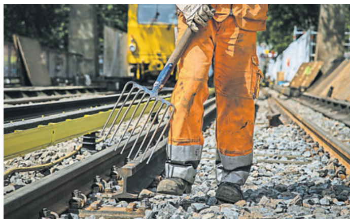
Gleisbauer arbeiten an den Verkehrswegen von morgen.
