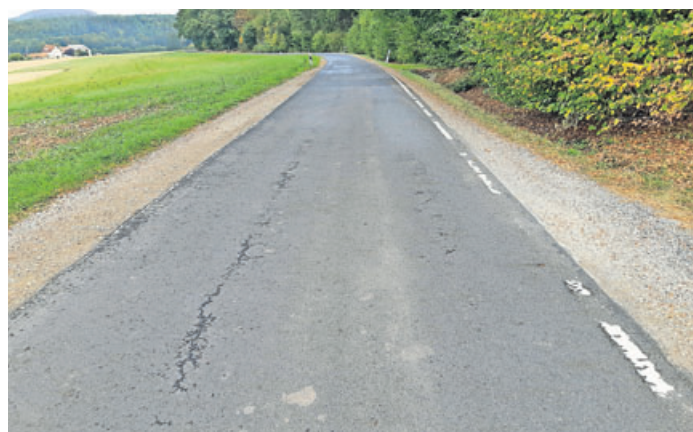
500.000 Euro soll die Fahrbahnerneuerung der Kreisstraße 22 im Streckenabschnitt zwischen Dipperz und der Kreisstraße 21 kosten.
