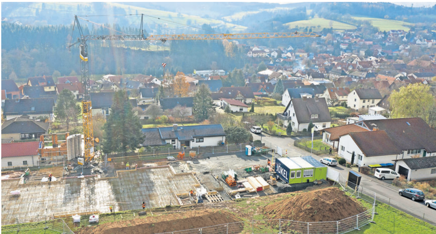
Der Bau der neuen Kinderkrippe in Gersfeld ist in vollem Gange.
