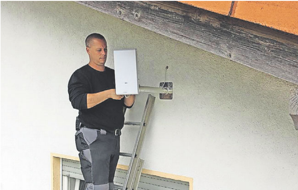
Bauhofmitarbeiter Karsten Göllner bei der Montage.
