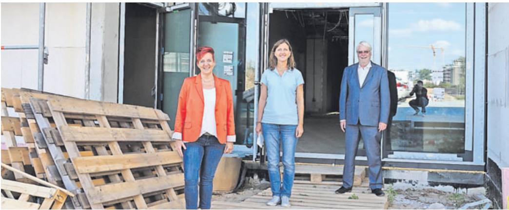
Carolyn Hartmann, Fachdienstleiterin „Kita-Büro“, die neue Leiterin der städtischen Kita im Quellenpark, Daniela Brüll, und Sozialdezernent Dr. Jörg-Uwe Hahn auf der Baustelle (von links).
