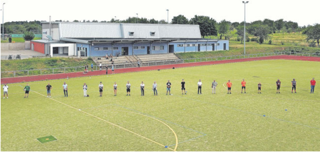
420.000 Euro plant die Gemeinde Wölfersheim für die Sanierung des Kunstrasens auf dem Singberg. Von dem Gelände sollen künftig die Singbergschule sowie Vereine profitieren.
