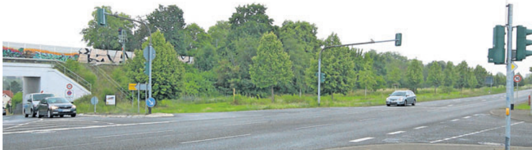
Bis März 2021 soll das neue Bad Nauheimer Gewerbegebiet erschlossen sein.
