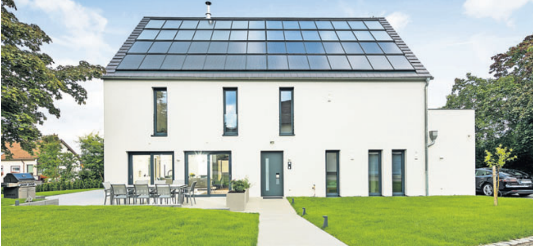
Große Photovoltaik- und Solarthermieranlagen auf diesem Plusenergiehaus erzeugen viel Energie für Wärme, Strom und Elektromobilität - mehr als der Haushalt selbst verbrauchen könnte. Foto: Udo Geisler/Gemeinhardt AG/dpa-mag
