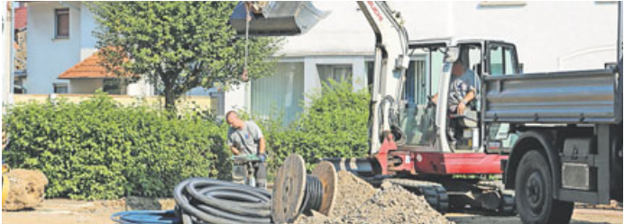
Bei den Bauarbeiten des Tanzhofes in Wölfersheim-Berstadt.
