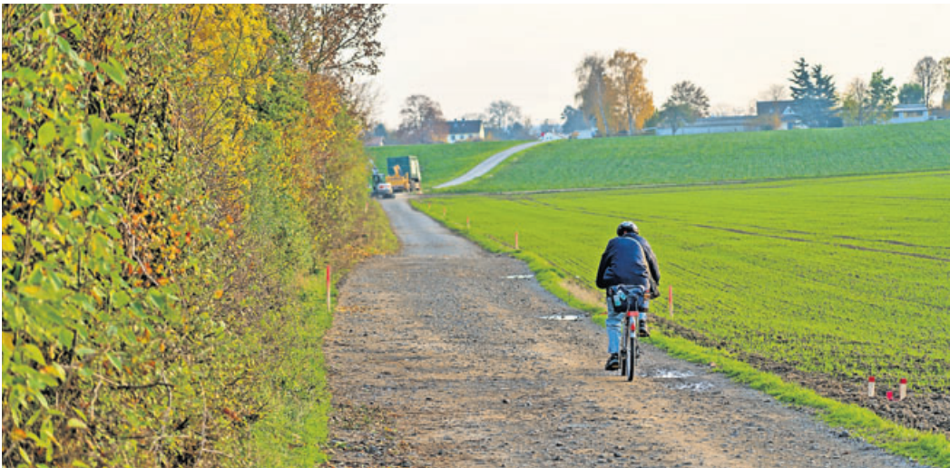
Der Karbener Weg kann endlich ausgebaut werden.
