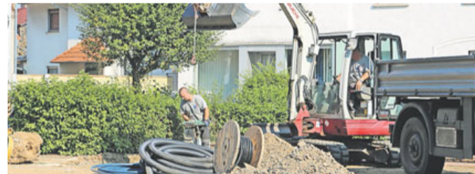
Bei den Bauarbeiten des Tanzhofes in Wölfersheim-Berstadt.
