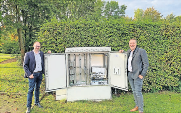
Glasfasertechnik in den Niddataler Städten.
